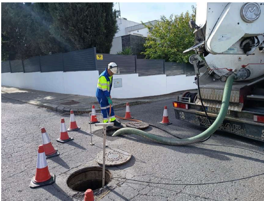
Operarios de Aqualia trabajan en la inspección de la red de saneamientos del Puente Tablas.
